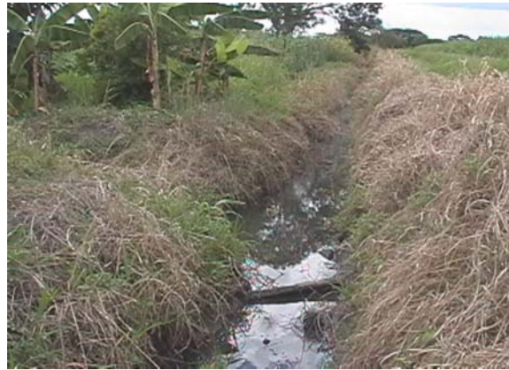
Foto 4. Canal conductor de agua para riego
